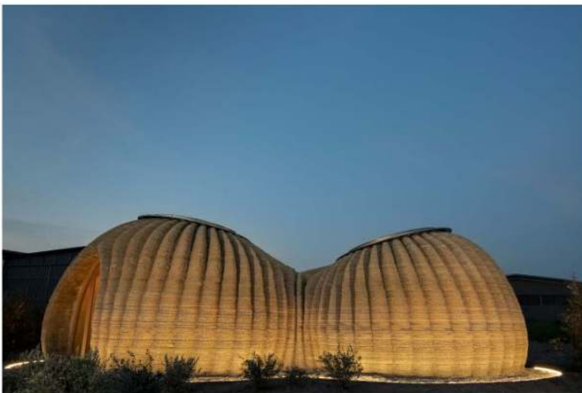
Come si presenta Tecla al termine dei lavori (foto, Iago Corazza)
